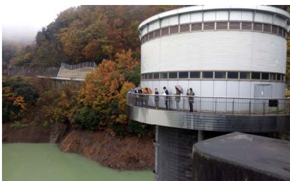
日吉ダム選択取水設備を視察
